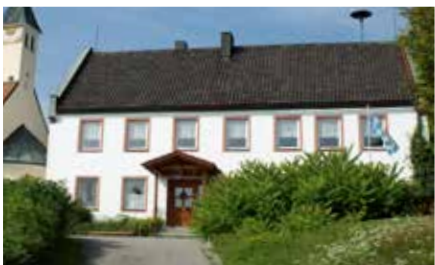
Schulungsraum der Feuerwehr Obermiethnach, Petersweg 13 2014
