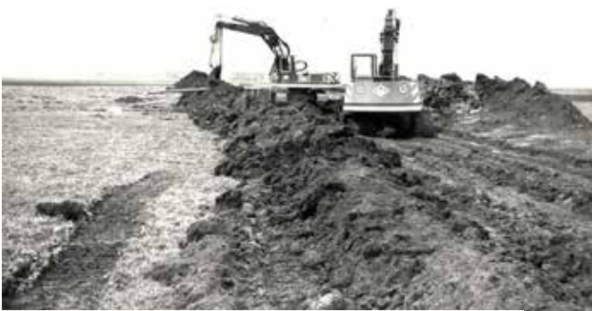
Wasserleitungsbau von Kößnach nach Pittrich 1980
