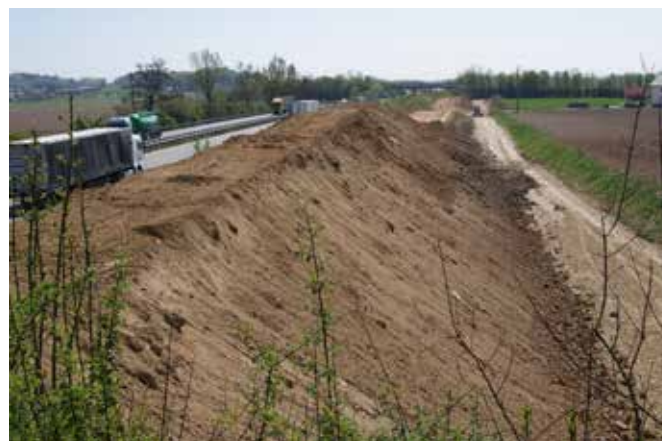
Bau Lärmschutzwall Thalstetten 2009-lfd. 2010
