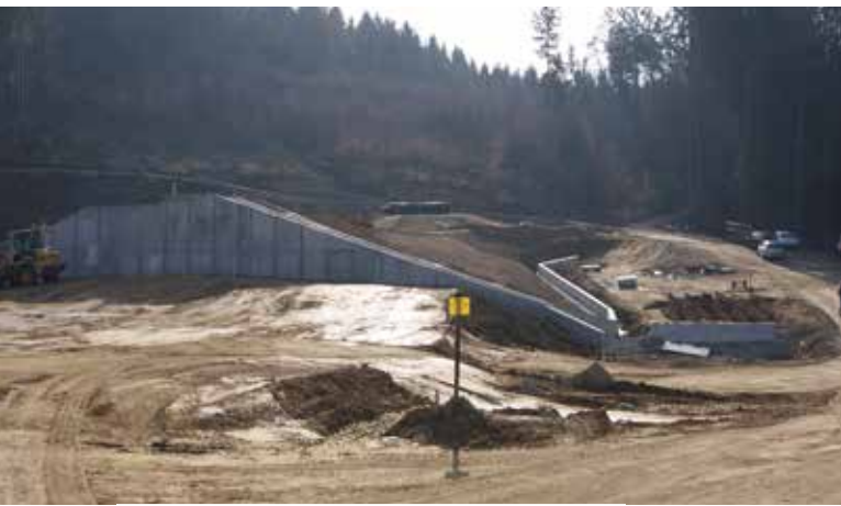
Baustelle Rückhaltebecken Aufroth 2012
