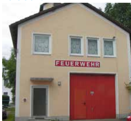
Feuerwehrgerätehaus Pillnach, Waldstraße 4 2017 Sigrun Kraus
