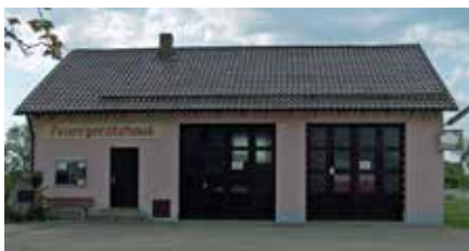
Feuerwehrrätehaus Kirchroth bis 2011 in der Feuerhausstraße 1 2008
