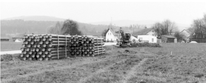
Wasserverbindungsleitungsbau von Thalstetten nach Aufroth 1987
