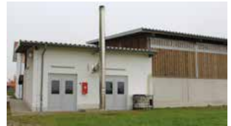
2010 erfolgte der Neubau einer Biomasseheizung 2017
