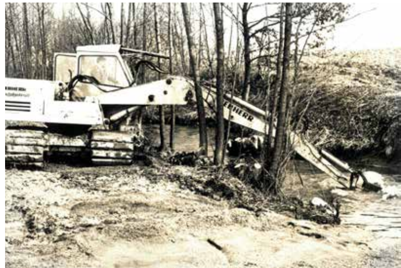
Räumung der Kößnach 1982
