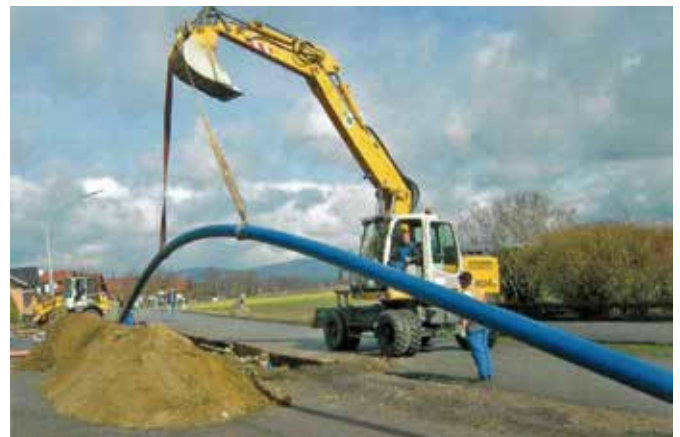
Erneuerung Wasserleitungen in Kößnach 2009 Broschüre „50 Jahre Zweckverband zur Wasserversorgung der Buchberggruppe“
