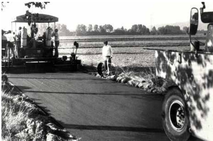
Asphaltierungsarbeiten für Gemeindeverbindungsstraße Weiher-Pittrich 1985
