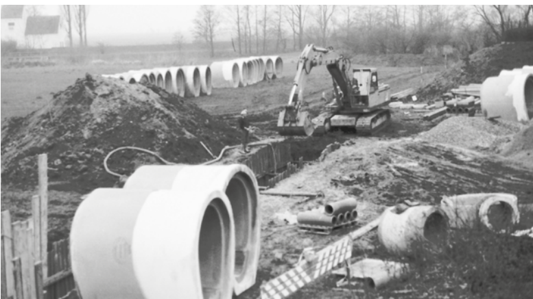
Bau des Stauraumkanals Köbnach 1984 im Bereich des Bolzplatzes
