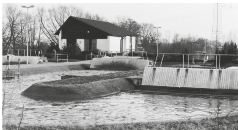
1981 Neubau der Kläranlage Bachhof 8
