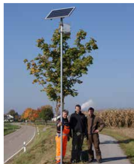
Solarleuchten für Geh- und Radweg Pondorf-Oberzeitldorn 2012
