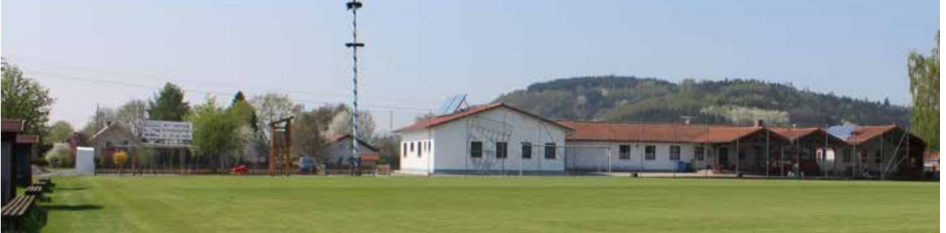
Sport- und Schützenheim Obermiethnach in Untermiethnach 18 a 2018
