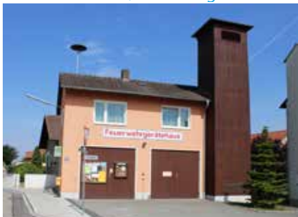
Feuerwehrgerätehaus mit Schulungsraum Oberzeitldorn, Hauptstraße 19, Bau 1964 2017
