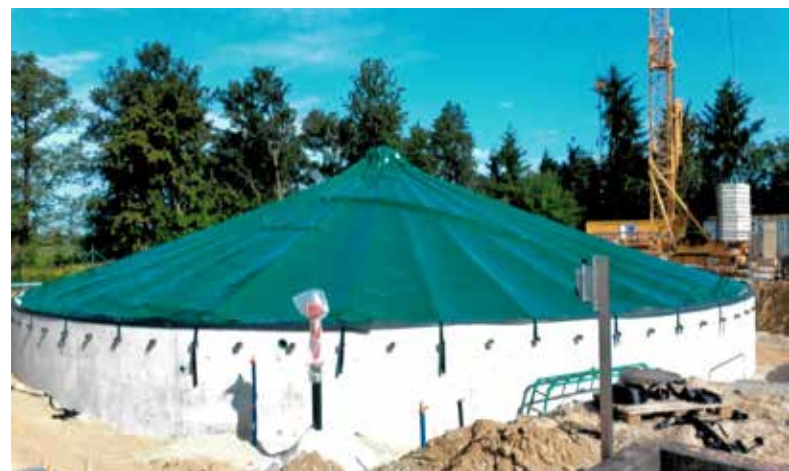
Kläranlage: Erneuerung Ausgleichsbecken und Vorlagebecken 2014
