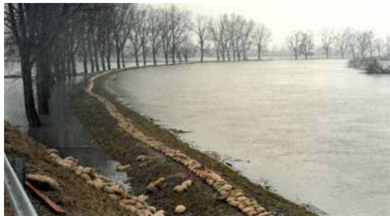
Dammstützungsmaßnahmen Christoph Kiefl
