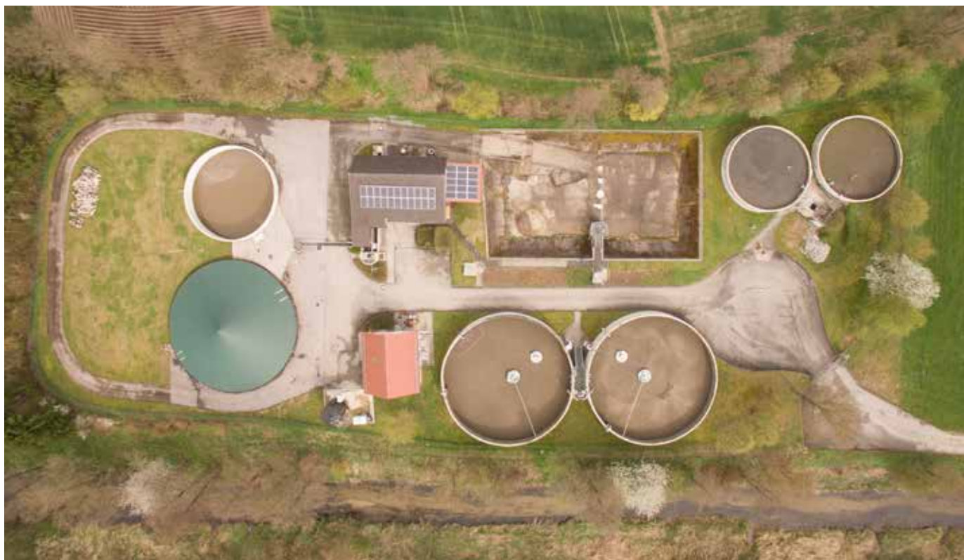
Drohnenaufnahme der Kläranlage Bachhof 8 Albert Kitzinger III 2018
