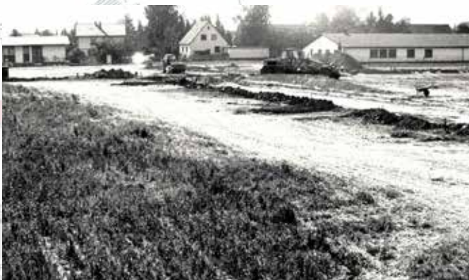
Erschließungsarbeiten Baugebiet Kapellenfeld BA I, Kirchroth 1982
