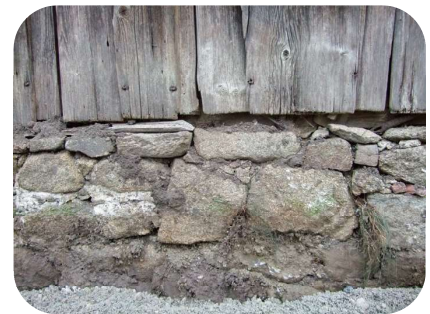
Altbestand vor der Instandsetzung: Bruchsteinsockel aus der Erbauungszeit, Verschalung von 1808 mit geschmiedeten Stiftnägeln (Foto: Erwin Hahn)
