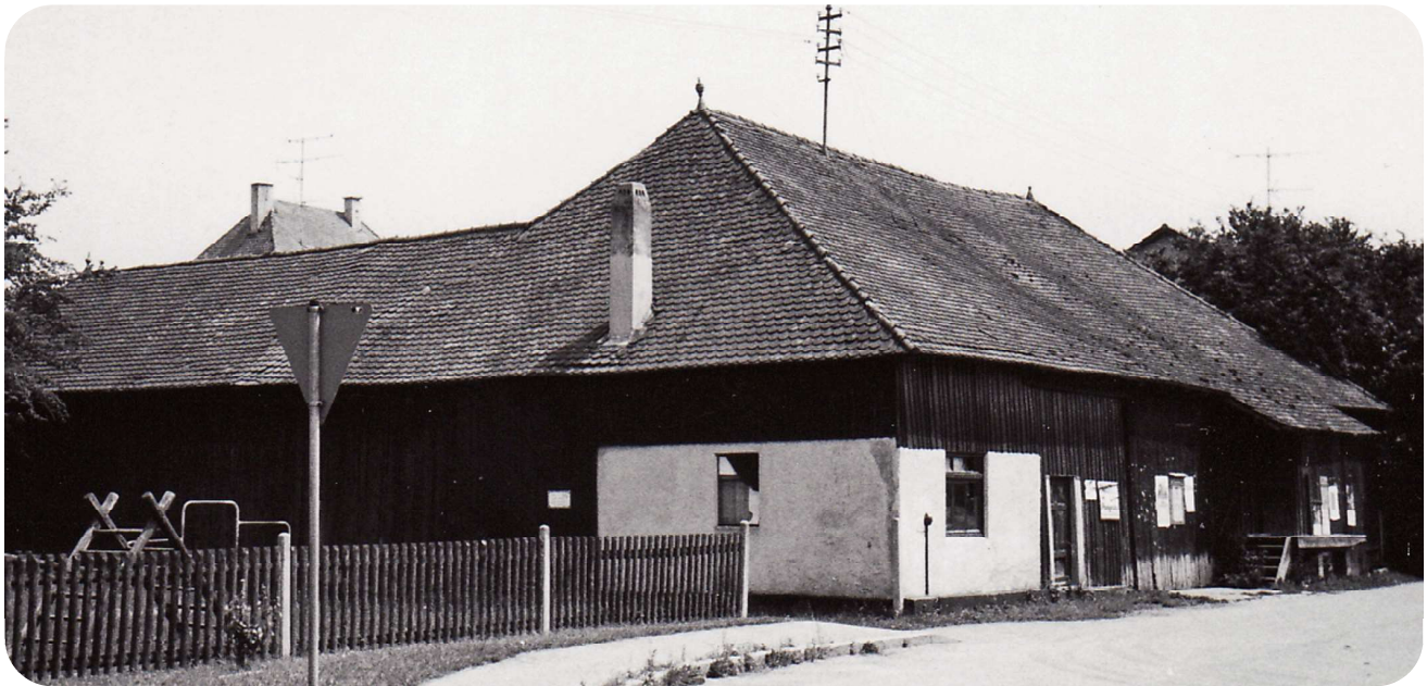
Pfarrstadel von Westen, 1993 links : die 1917 angebaute Remise, Mitte : der Büroeinbau für das Lagerhaus, rechts : die Laderampe für das Lagerhaus. (Foto: Erwin Hahn)
