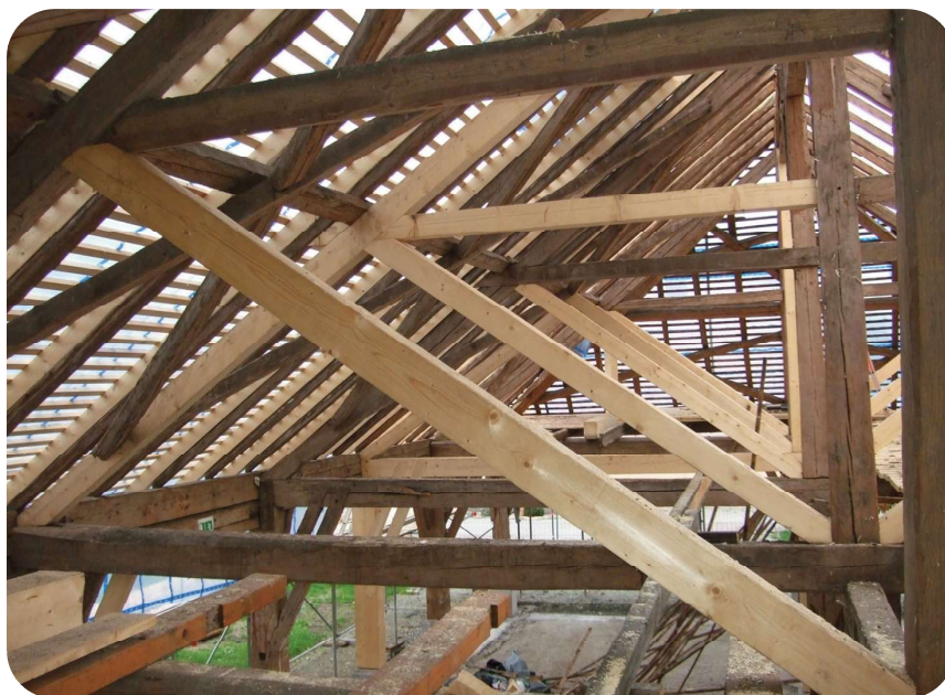
Statische Unterstützung der Dachkonstruktion. (Foto: Erwin Hahn)
